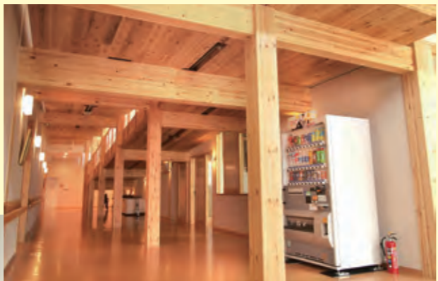
軽くて強度のあるCLTを車いす用のスロープ材として利用。見た目にも木のぬくもりが感じられるCLTは、非構造用部材としても活用度が高い
